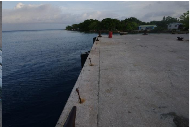
Rusted Steel Struts - Jaluit
